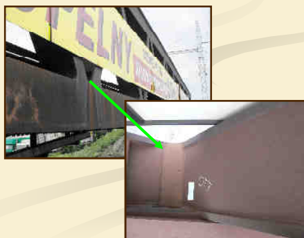
Železniční most Brno-Komárov
