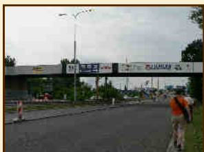
Pohled na konstrukci
