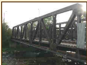
Pohled na konstrukci
