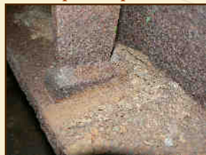
Dolní pásnice příčnicku
