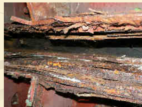
Konstrukce pod dilatací
