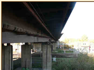
Pohled na konstrukci
