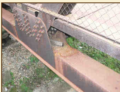
Železniční vlečka v Krnově
