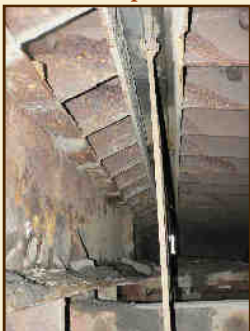
Konstrukce pod dilatací
