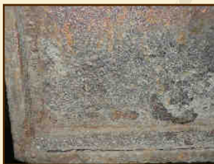
Hlavní nosník pod mostním závěrem
