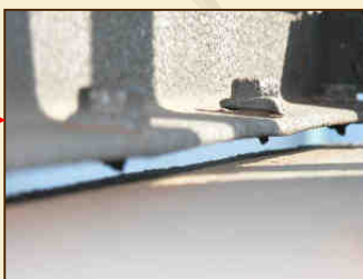
Osvětlovací stožár ve Vítkovicích (1974)
