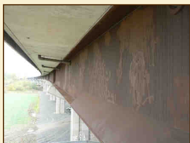
Ostrava, D1, estakáda přes trat' ČD a řeku Opavu (po 4 letech expozice)
