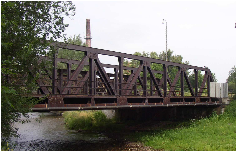
Obr. 6 : Železniční most z oceli Atmofix
