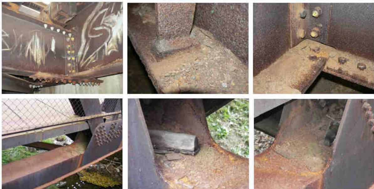
Obr.1 Nepříznivý vývoj patiny na prvcích železničního mostu přes řeku Opavici
